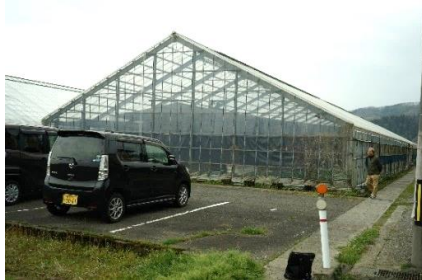
ハウスは幅15m、長さ70・65・58mの3つ。①②③号ハウスと呼んでいる。①号ハウスでは、ブドウと野菜を栽培。②③号ハウスでは切りバラを栽培。鉄骨の堅牢な建築物で台風にも耐える
